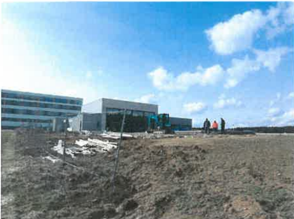
Abb. 3: Blick von Südosten auf das Baufeld (03/2013)
