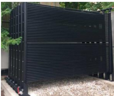
Abbildung 7: Absorber Aufständerung im Paketverbund
