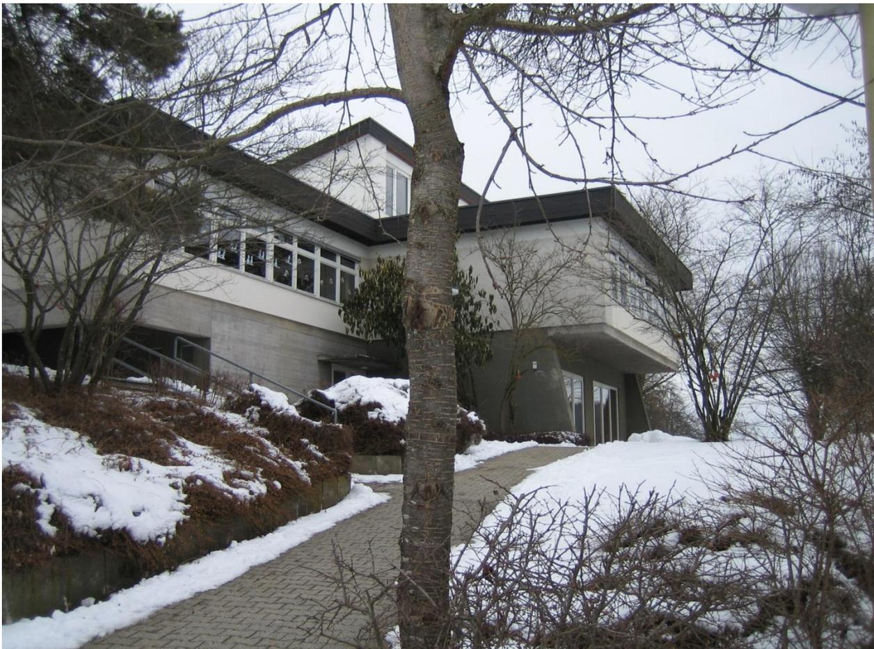
Die Fenster sind derzeit als Isolierglasfenster in Holzrahmen ausgeführt, sollen aber im Laufe dieses Jahres durch neue Fenster ersetzt werden.
