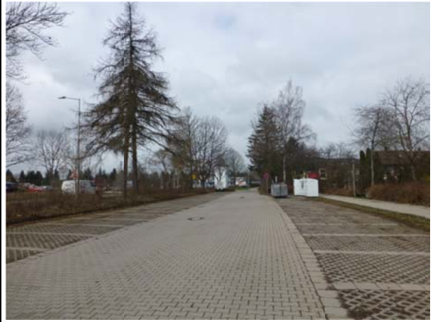
Blick nach Westen, Parkplätze
