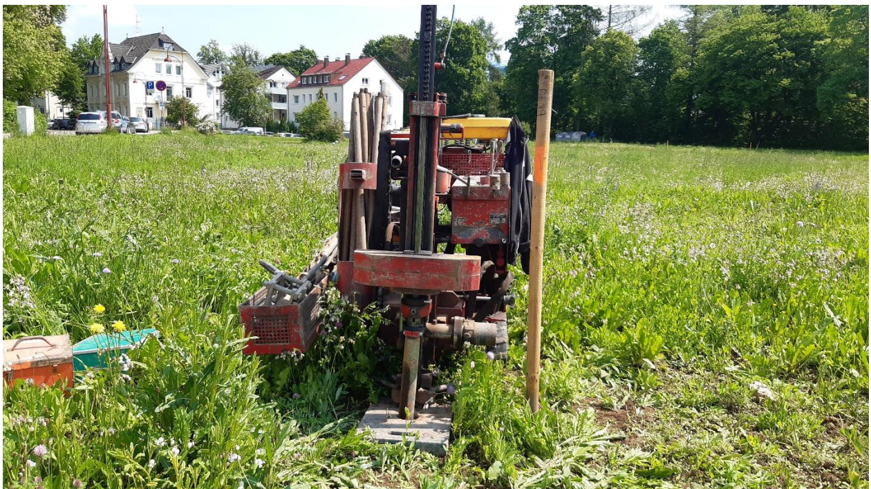
Abbildung 4 Durchführung der Rammkernsondierungen mittels Raupenbohrgerät am 09. und 10.06.2021
