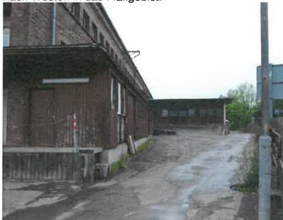
Foto 3: Nord-östliche Ecke des Plangebiets; Blick nach Westen entlang der Mauer zur L 173.
