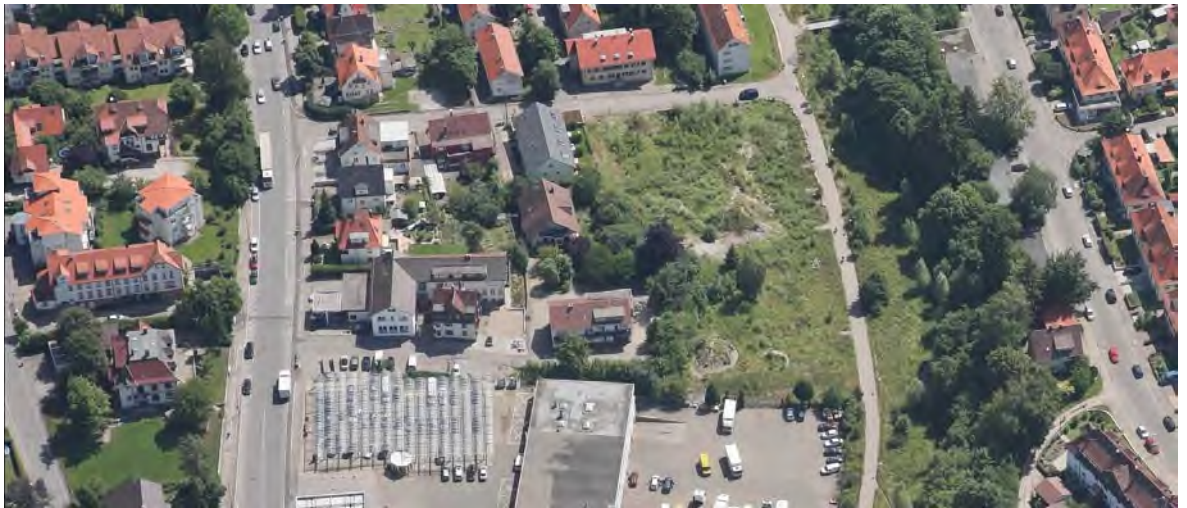
Abb.: Schrägaufnahme aus westl. Richtung
