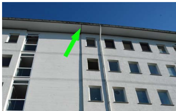
Abbildung 6: Gebäude mit Dehnungsfuge mit Quartier der Breitflügelfledermaus (Grüner Pfeil)
