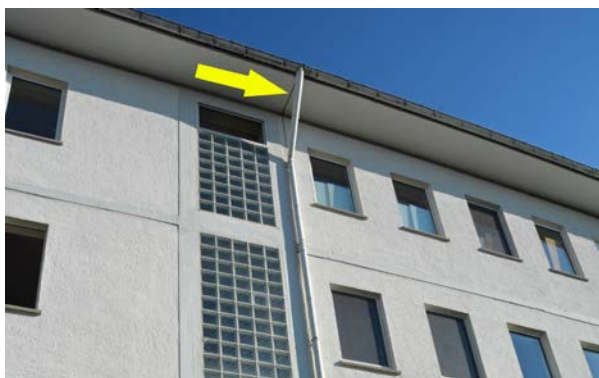
Abbildung 7: Gebäude mit Dehnungsfuge mit Quartier des Abendseglers (Gelber Pfeil)
