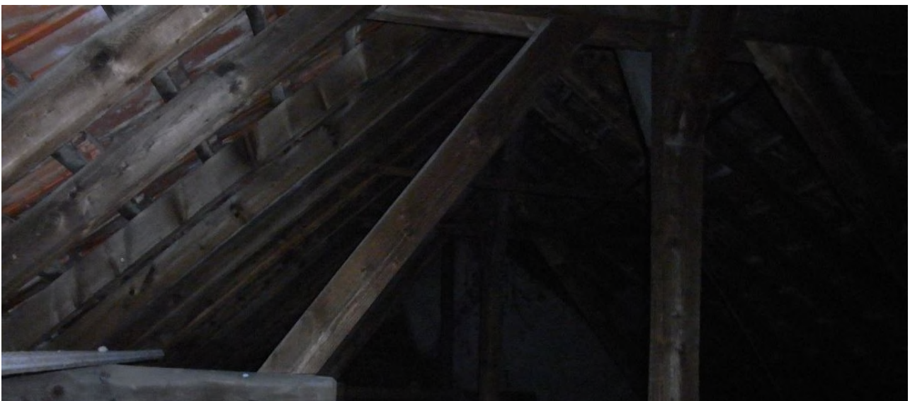
Abb. 8: Für Fledermäuse frei zugänglicher Dachstuhl in einem Schuppen.
