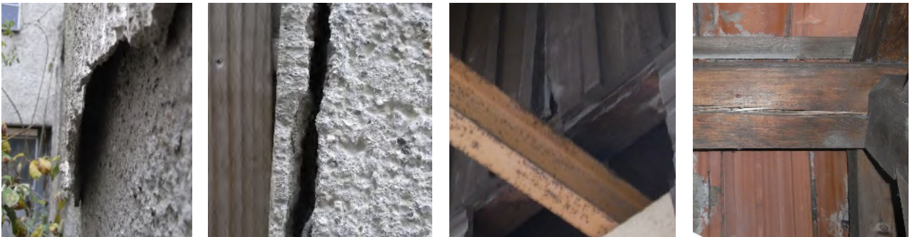
Abb. 7: Potenzielle Hangplätze für Fledermäuse in Spalten in der Fassade (links, Mitte links) sowie hinter der Holzverkleidung (Mitte rechts, Bruchstelle in der Latte) und im Dachbalken eines Schuppens (rechts).
