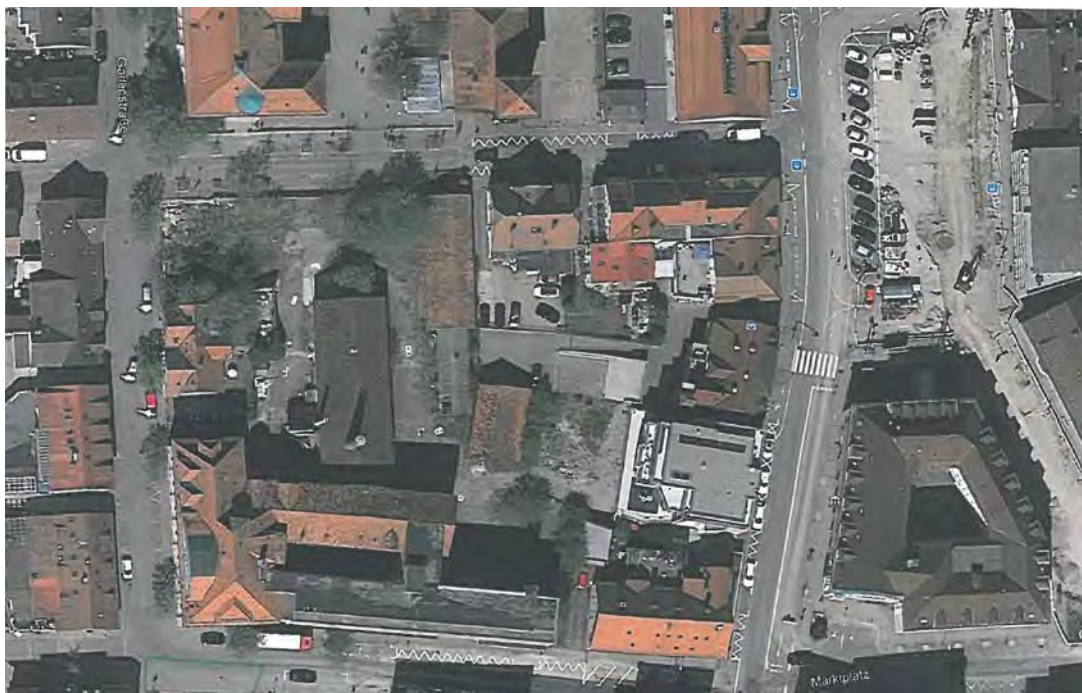
Luftbild des Bestands vor dem Abbruch 2017 (LUBW)
