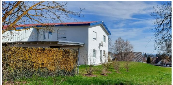
Standort: Westlich Plangebiet / Blickrichtung: Nordosten, Sicht auf das bestehende Nachbargebäude (Foto: J. Mauch, 22.03.2024)
