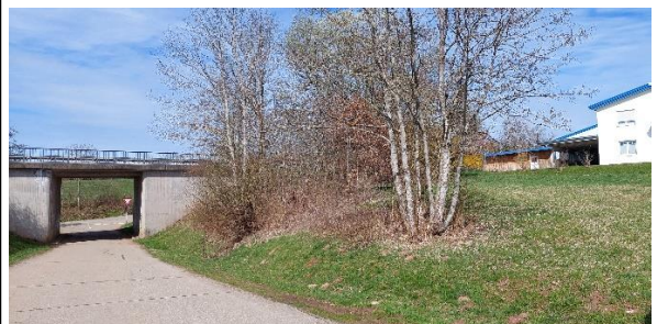
Standort: Südlich Plangebiet / Blickrichtung: Nordwesten, Sicht auf den Gehölzbestand und die Fahrbrücke (Foto: J. Mauch, 22.03.2024)
